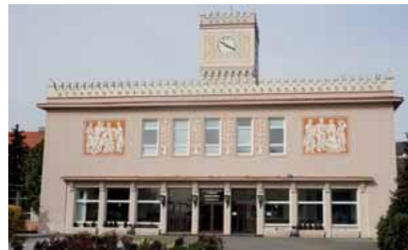
↑ Obr. č. 7: cimburie a atika na vstupom trakte a bočných krídlach študentského domova, autor: Emil Belluš.
