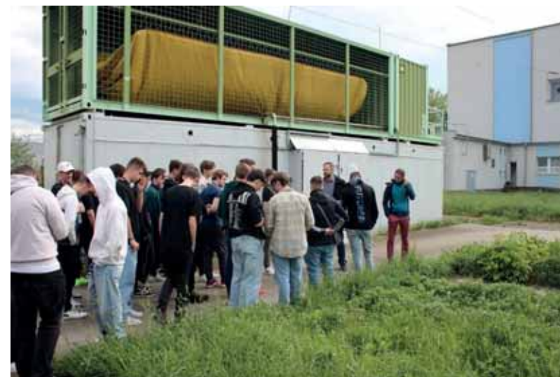
↑ Exteriér Laboratórií vysokých napätí. V pozadí bioplynová stanica.
