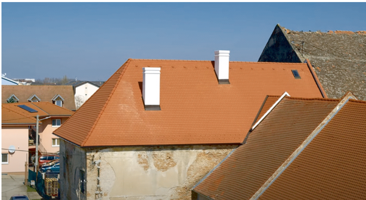
Obr. 8.: Zrealizovaná rekonštrukcia komínov a strešnej krytiny (Zdroj: Zdeno Krump)
