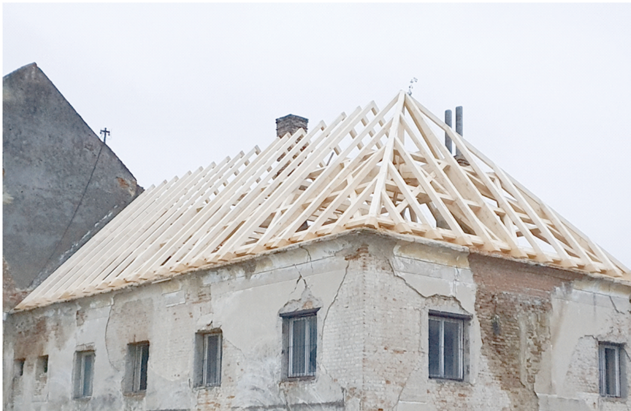
Obr. 7.: Zrealizovaná nosná časť krovu (Zdroj: Zdeno Krump)
