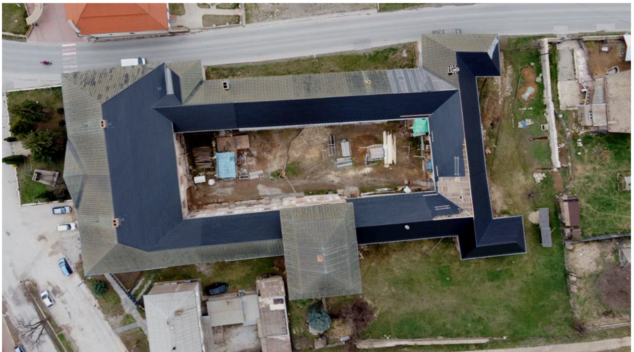
Obnova strešného plášť, apríl 2021
