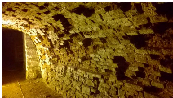
Práce na obnove poškodeného muriva v suteréne
