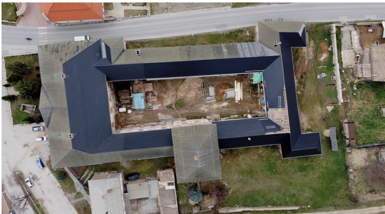
Obnova strešného plášť, apríl 2021
