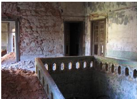
Rok 2015 – vypratávanie sutiny a stavba dočasnej konštrukcie pre bezpečný pohyb
