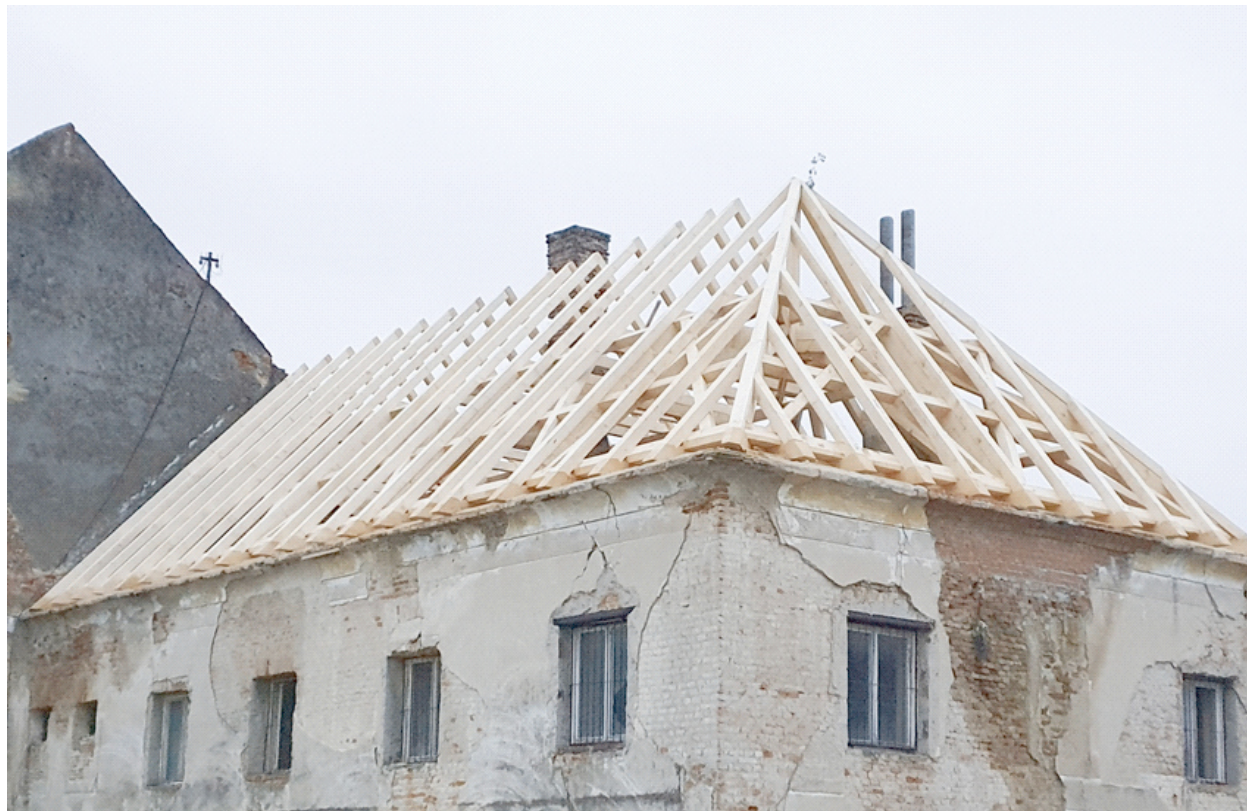
Obr. 7.: Zrealizovaná nosná časť krovu (Zdroj: Zdeno Krump)
