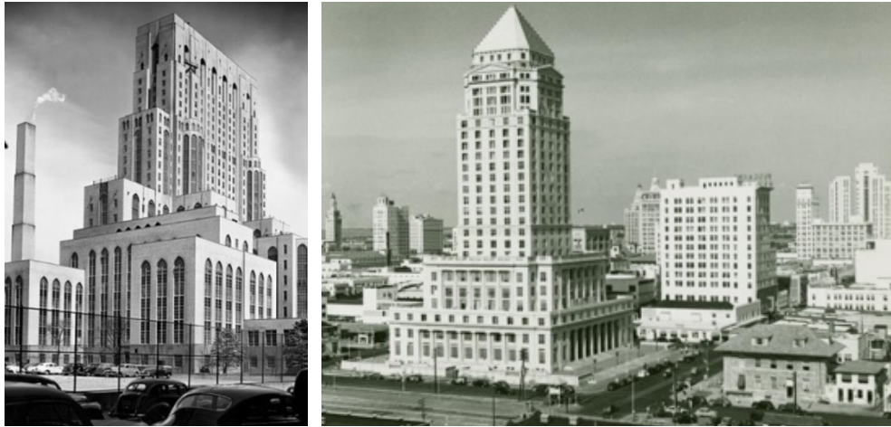
Obr. 27: New York Hospital, 1929 a Dade County Courthouse v Miami, 1928, medzi prvými monolitickými hybridnými budovami v USA. Zdroj: [Fenton1988:s. 34 a 35].
