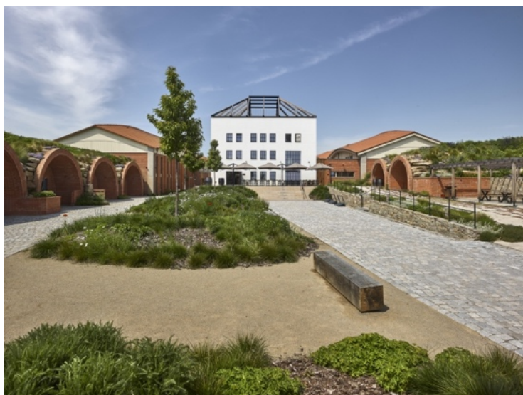
Obr. 76: Zážitkové vinárstvo Thaya, autor: Ing. arch. Jakub Cigler a kolektív, Havraníky, 2022. Zdroj: [online] https://jakubcigler.archi/vinarstvi-thaya .
