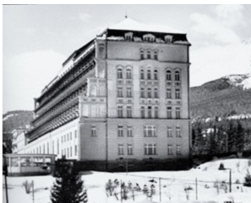
Obr. 4: M. M.Harminc, Sanatórium Dr. Szontágha, Nový Smokovec, pohľad na južnú terasovitú fasádu, predznamenávajúcu nástup modernej architektúry na Slovensku. Zdroj: http://living.hnonline.sk/clanky/hnreality/sest-dekad-neunavnej-prace
